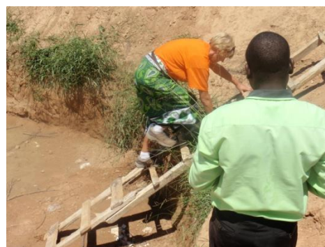
Ik klim hier in de kuil waarin de watertank gebouwd gaat worden
