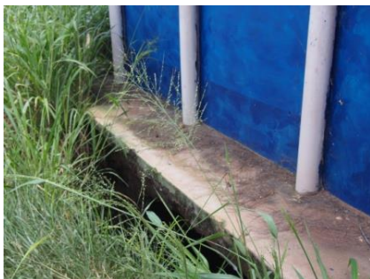
De fundering is onder de toiletten weggespoeld
